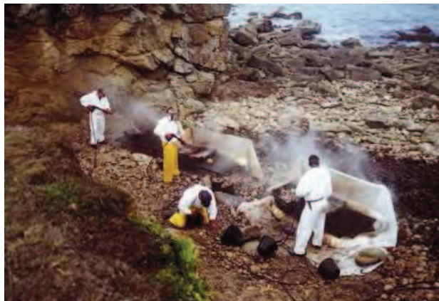
Lavage de galets sur site (Source : Cedre)
