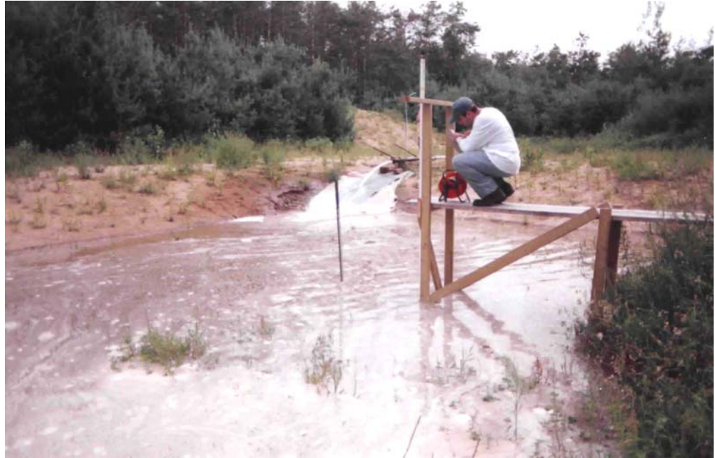
Illustration 4: Bassin avec des bords en sable sur un revêtement géotextile HDPE
