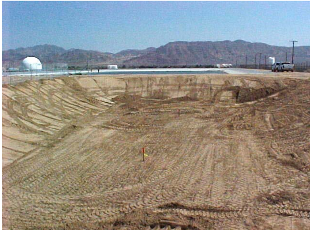
Illustration 2: excavation de bassin
